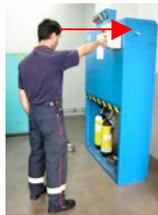
**7°.** Presionar botón de cierre de color rojo del cuadro del armario hasta que la compuerta del armario baje totalmente y el zumbador acústico deje de sonar
