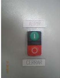
**1°.** Abrir la compuerta frontal del armario de carga manteniendo el pulsador verde de la botonera apretado hasta que suba totalmente.
