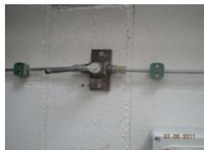
**10°.** Verificar que la llave de paso de la tubería de aire esté abierta
