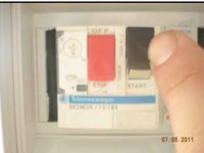
**9°.** Accionar el contactor ubicado en el lateral del compresor para permitir el paso de corriente
